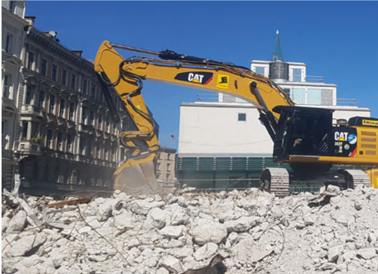
Zwei Cat Kettenbagger 352F knöpfen sich die unteren Stockwerke vor
