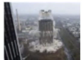
Sprengung AfE-Tower, Frankfurt, 02.02.2014
