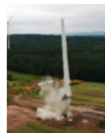
Sprengung Schneebergerhof 2021 durch patentierte Sprengfaltung.
