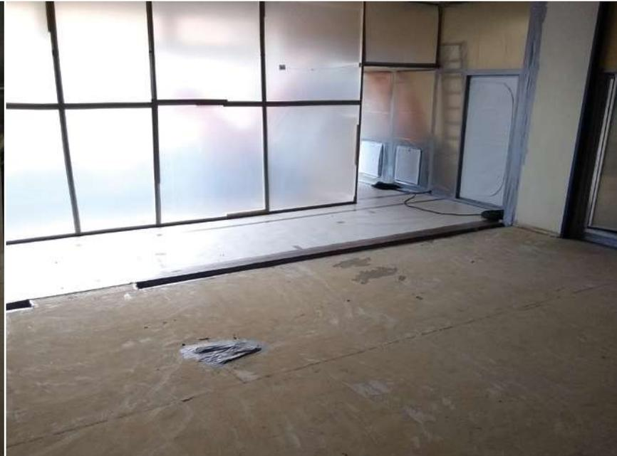
Gereinigter Schwarzbereich nach Rückbau einer Leichtbauwand mit asbesthaltigen Spachtelmassen und Entfernung des asbesthaltigen Bodenbelags.
