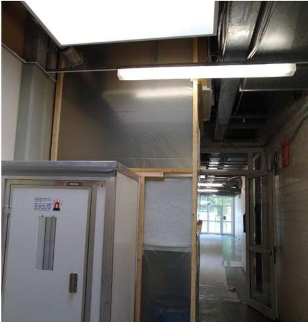
Schwarzbereich für das Trennen einer Asbestzementleitung
